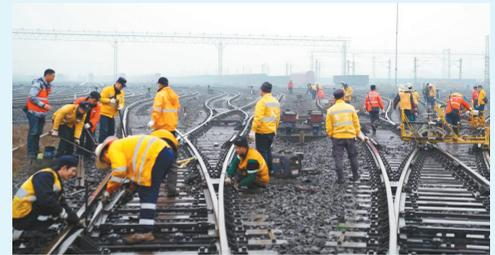
春运开启后,重庆市沙坪坝区兴隆场编组站随即开展春运设备整治施工。重庆电务段、兴隆场车站、重庆工务段每日召开施工对接会,紧密配合。重庆电务段施工负责人唐东旭介绍,施工内容包括更换制动轨、制动钳、气缸等关键部件,校核测长区段,清理基础平台,以及对控制箱和辅件箱进行清理与刷油漆。此外,还涉及更换轴销、制动缓解风管,以及进行钢件更换和道岔打磨等工作。此次驼峰春整施工完成后,能提升设备运用质量,延长使用寿命,为春运列车编组安全及中欧班列提效筑牢根基。
