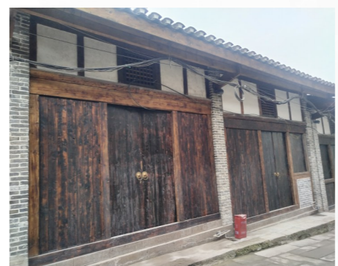
修缮后的古镇建筑
