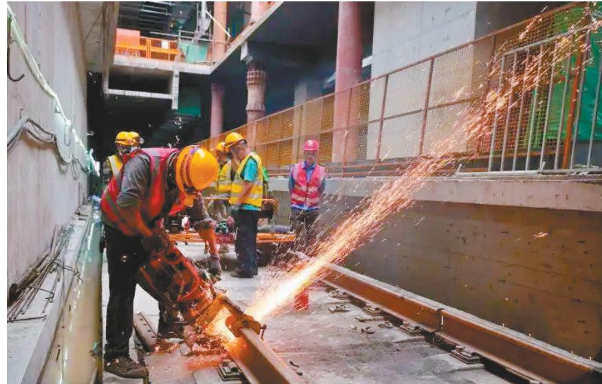
5月6日，在迎龙站至商贸城北站区间施工现场，伴随着焊机规律的震动声，现场火花四溅，作业人员操作移动式闪光焊机完成了第一对钢轨头的无缝焊接，标志着重庆轨道交通24号线一期工程正式进入长轨焊接阶段，距离通车又近了一步。
