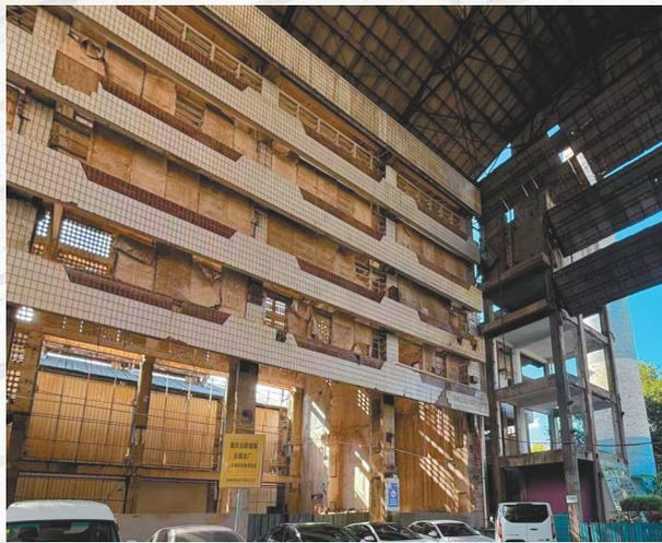
未经改造的厂区一楼外墙，有些瓷砖已经脱落。
